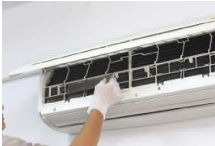
รูปที่ 10-16 การทำความสะอาดฟิลเตอร์กรองอากาศหรือแผงคอยล์เย็น
